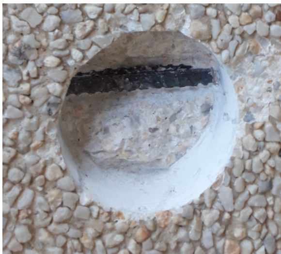
Figuur 3.1. Destructieve controle attributieve eigenschappen van het wapeningsstaal op locatie H3.1
